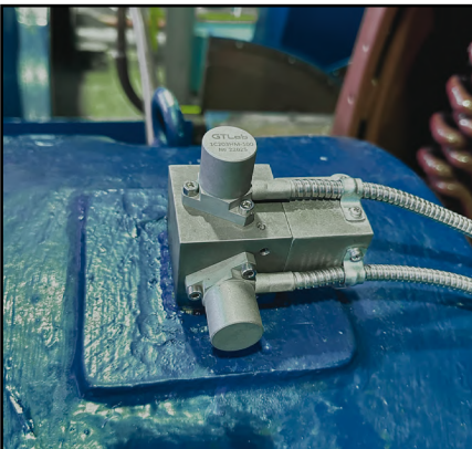
Установка акселерометров 1С203НМ-100 на электродвигатель и редуктор ГПА
